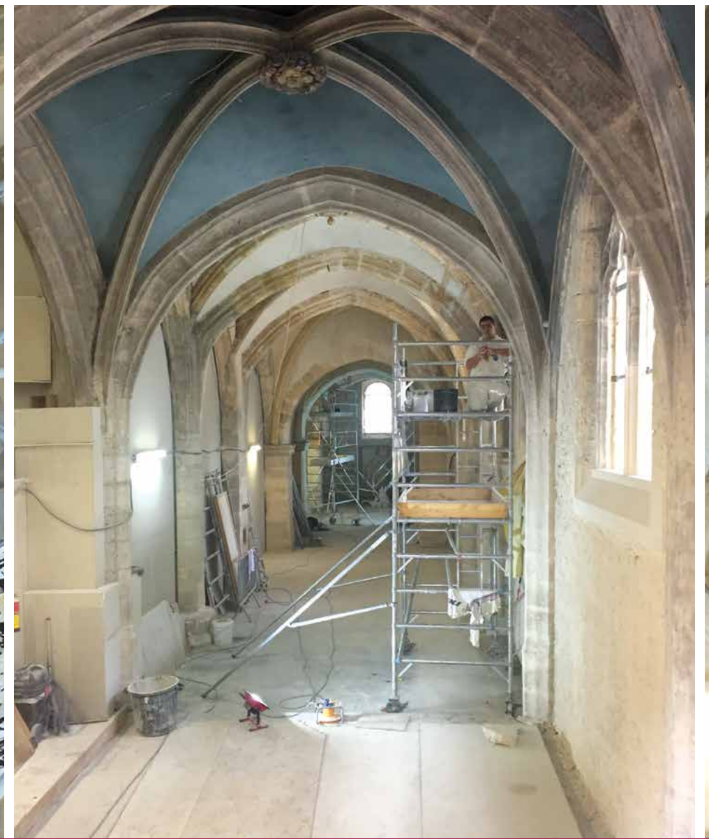
Nettoyage des voûtes et parements intérieurs par l'entreprise Mériquet (juin 2017)
