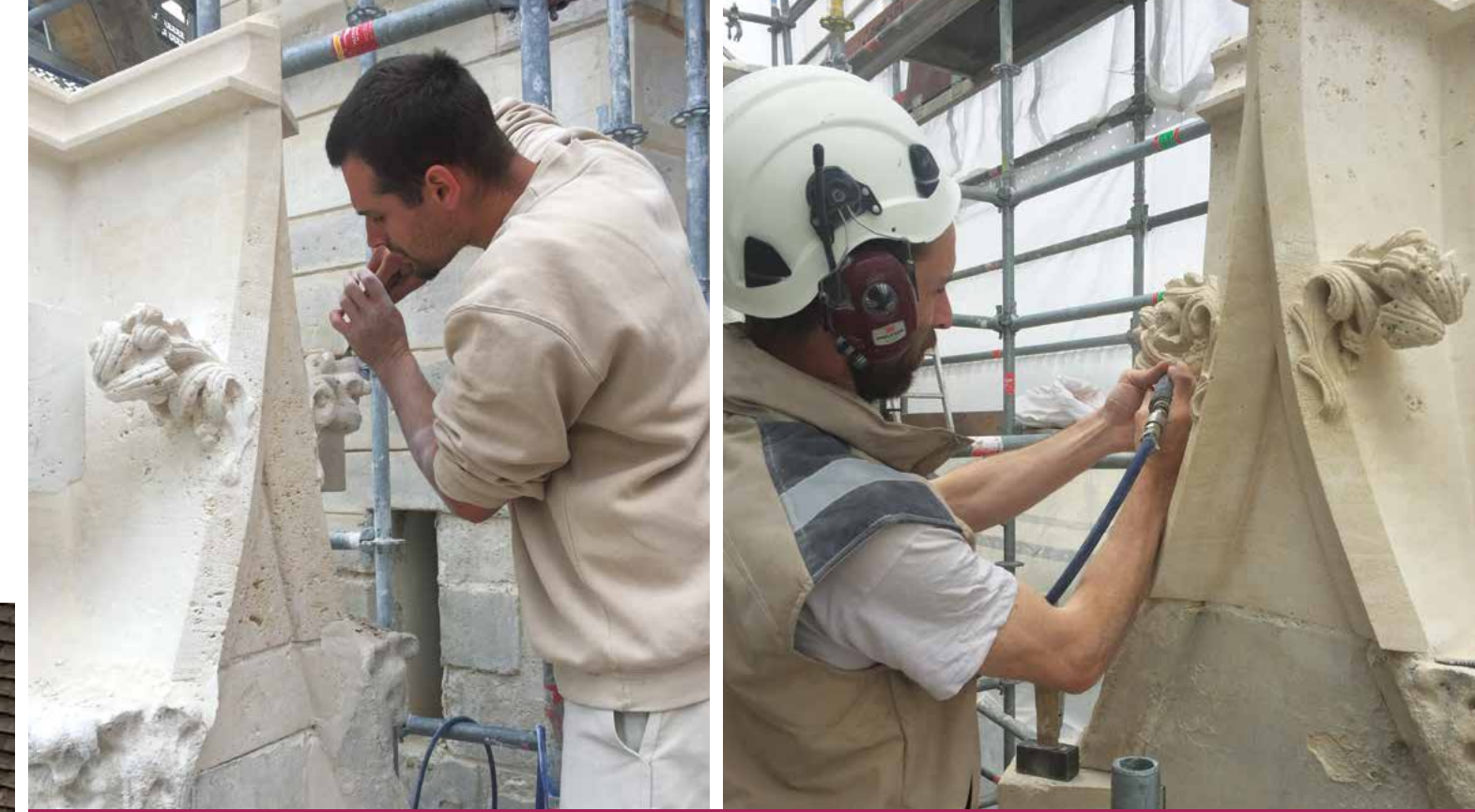
Travail de sculpture sur les chimères et crochets des pinacles du bas-côté nord de l'église par l'atelier Tollis (juin 2017)
