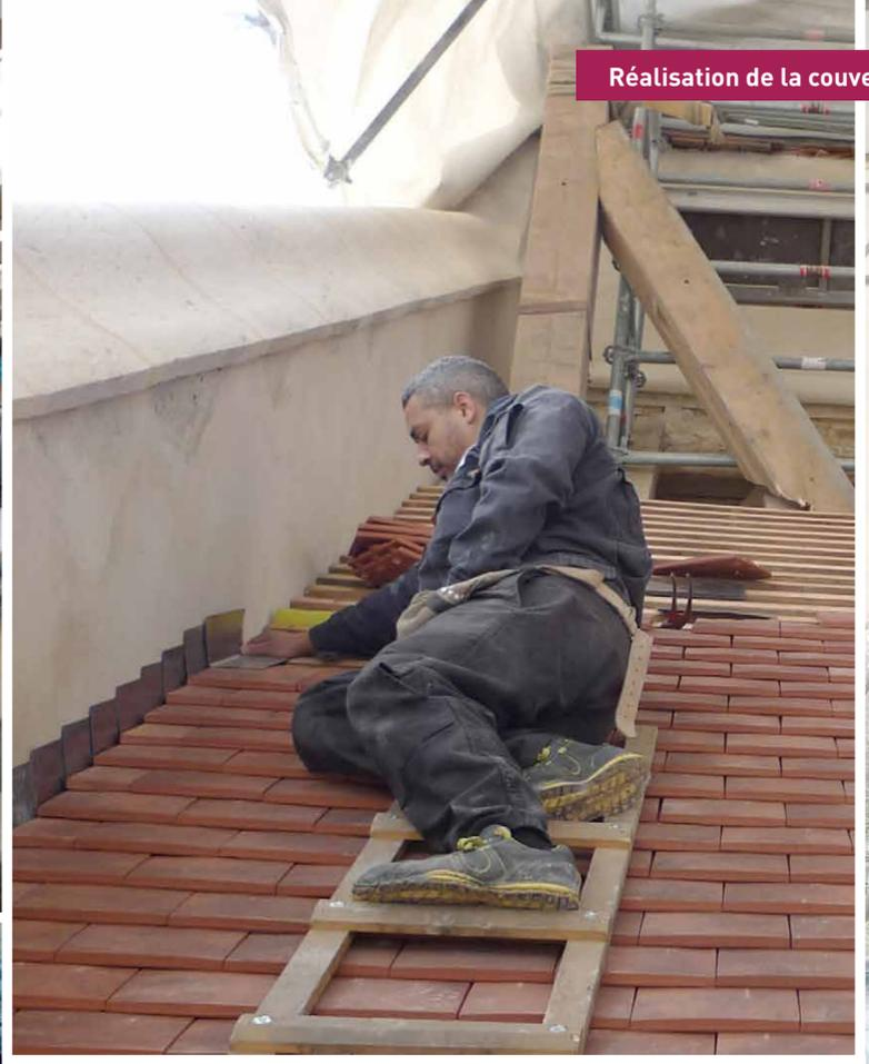
Réalisation de la couverture en tuiles plates
