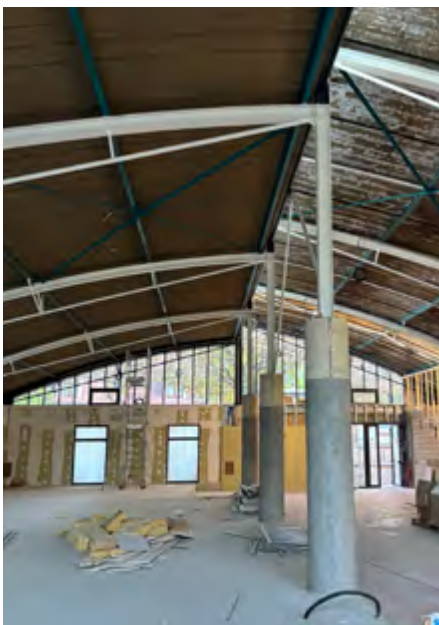
Travaux en cours dans le futur espace Sport et santé.
