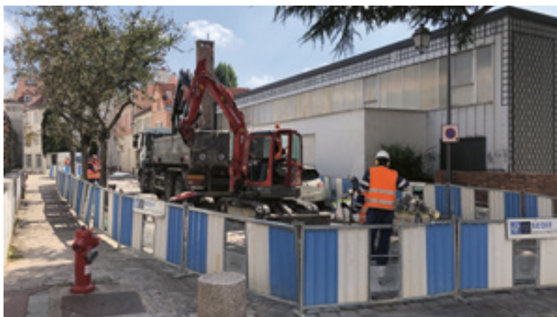
La rénovation de la conduite d'eau potable se poursuivait début septembre dans la rue des Imbergères, en prévision d'un vaste programme de restauration des voies et places du centre-ville.
