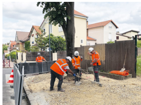
Mi-mai, la Ville réalisait des travaux de reprise d'un trottoir avenue de la Gare, entre la place et la rue des Clos-Saint-Marcel.
