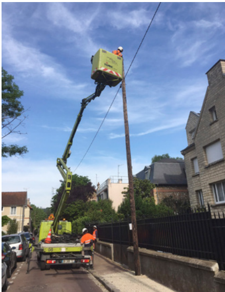
Le 19 mai, le Sipperec, Enedis et la Ville procédaient à l'enfouissement des réseaux rue Pasteur.
